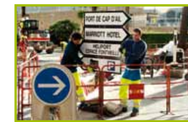
Installation par la DAU des nouveaux panneaux de signalisation
